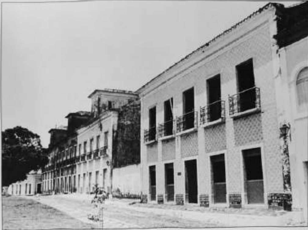
Fachada da Casa do Divino
